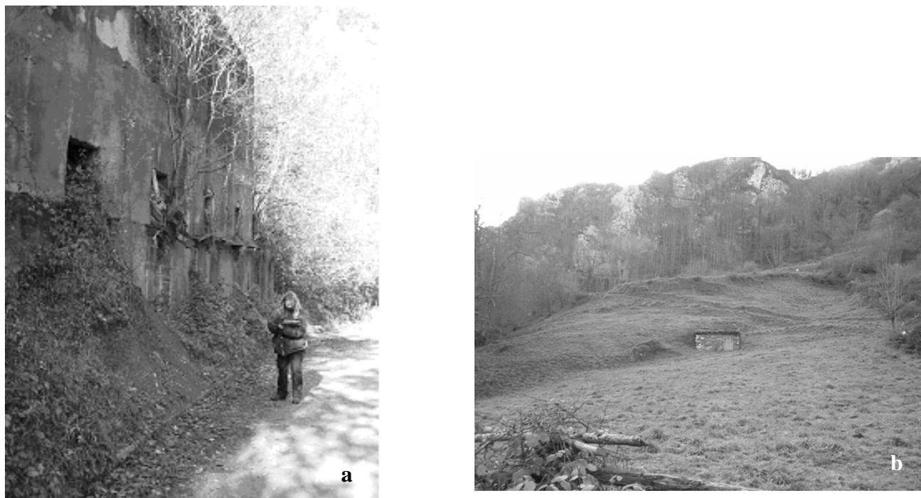
**Figura 10.- a.** Aspecto de la tolva minera de la Mina de Pandanes. **b.** Movimiento en masa y evidencias de reptación superficial.
