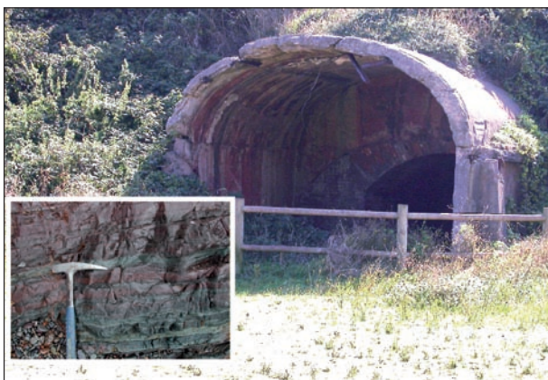
Figura 6. Bocamina de Llumeres, donde se explotaba el hierro sedimentario de la Formación Furada. En la parte inferior, aspecto de las capas de areniscas ferruginosas.
