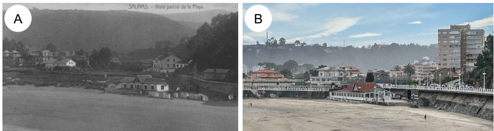
Fig. 8. (A) Vista parcial de la Playa de Salinas en 1920 donde observamos que la segunda sede del Balneario de Salinas era la única construcción en primera línea de playa (fotografía tomada del repositorio Memoria digital de Asturias). (B) La misma fotografía en 2023 permite constatar la degradación del campo dunar en esta zona.
